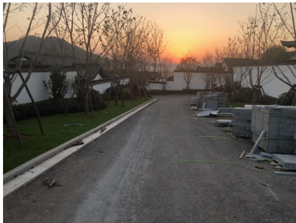
项目区内硬化道路
